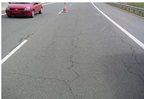
Figure 12.1 : Chaussée à assise traitée aux liants hydrauliques endommagée par fissuration de fatigue
