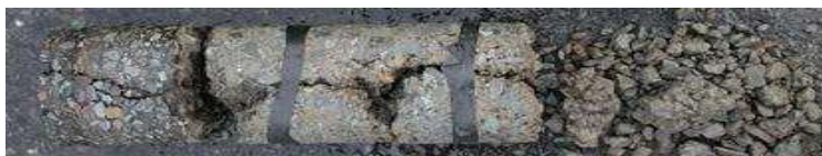
Figure 12.2 : Carotte sur chaussée endommagée par fissuration de fatigue
