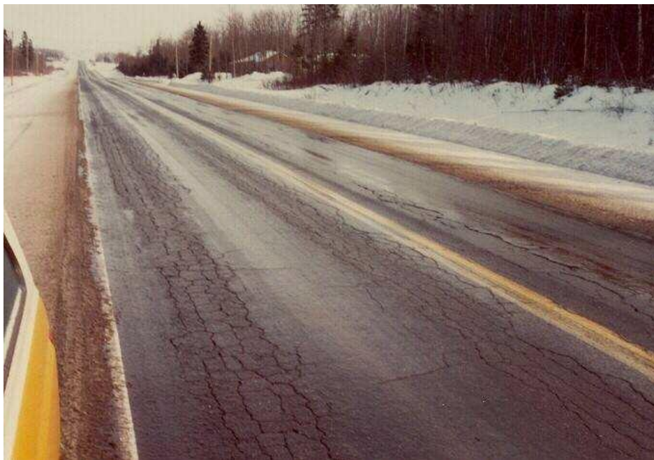
Figure 13.1 : Dégradation d'une chaussée sous l'effet du gel-dégel
